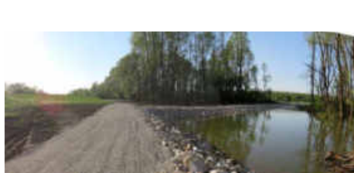
9. Novoizgrađena pera (pogled prema zapadu)
