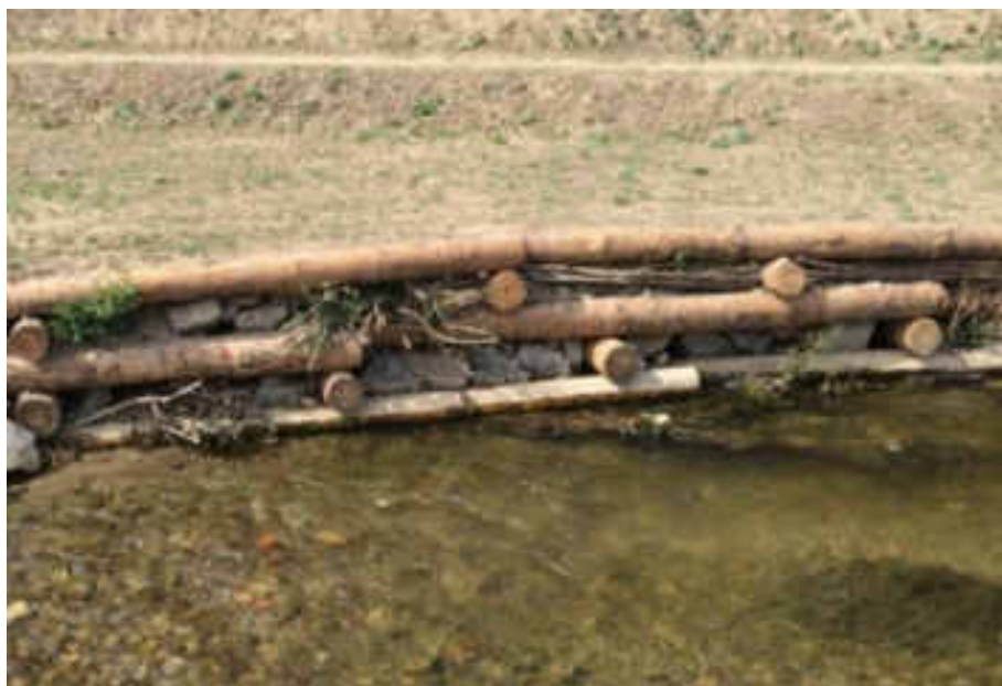
Slika 2-31 Biološka vodogradnja tipa drveni sanduci
