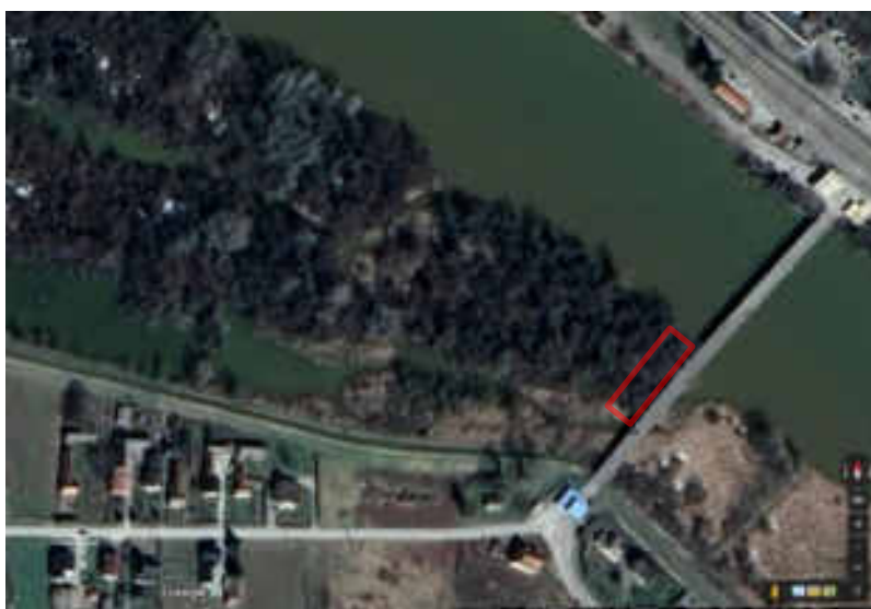
Slika 2-34 Uklanjanje vegetacije (crveno označeno) u području uzvodno od mosta
