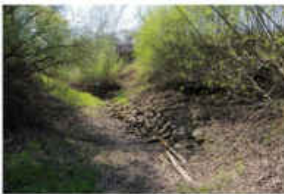
2.2.2.6. Ostaci stare kamene obloge za zaštitu desne obale rijeke Drave
