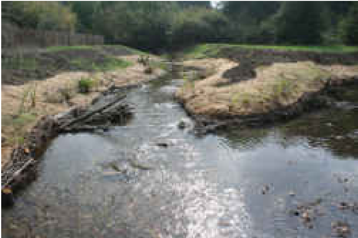
Slika 2. Primjer biološki prihvatljivih obaloutvrda. Izvor:
