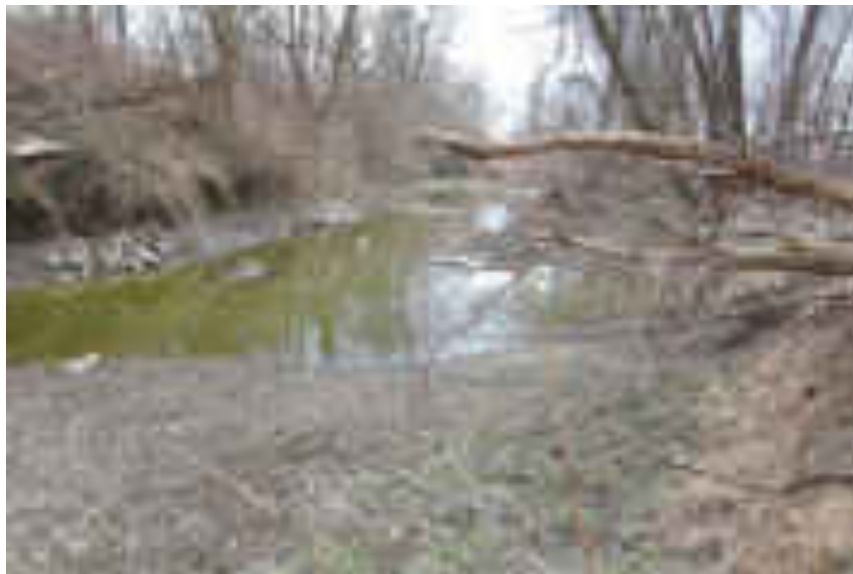
Slika 2.1.2.9. Ostaci stare kamene obloge protiv erozije desne obale (obala prema nasipu) „aktivnog“ rukavca uzvodno od ušća rukavca C.3.2.
