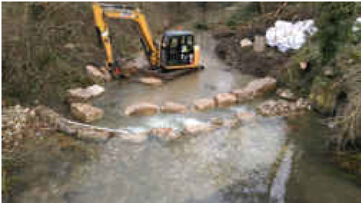
Slika 3. Izrada praga u vodenom tijelu korištenjem samica krupnog promjera
