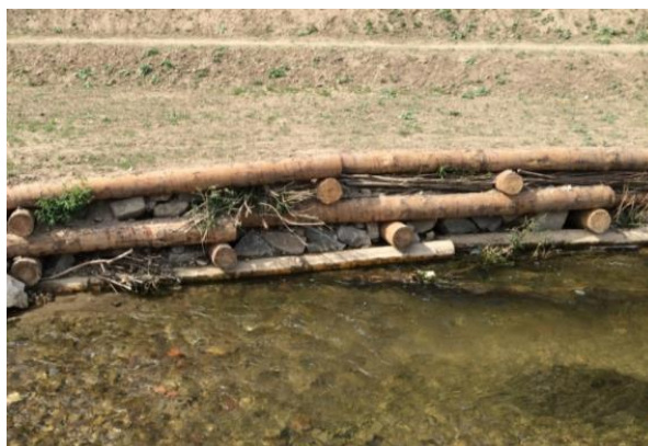
Slika 2-32 Prikaz karakterističnog izgleda biološke vodogradnje tipa drveni sanduci
