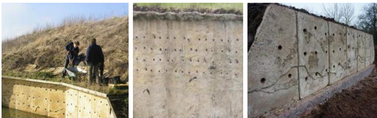
Slika 2-36 Primjeri umjetnog gnjezdišta
