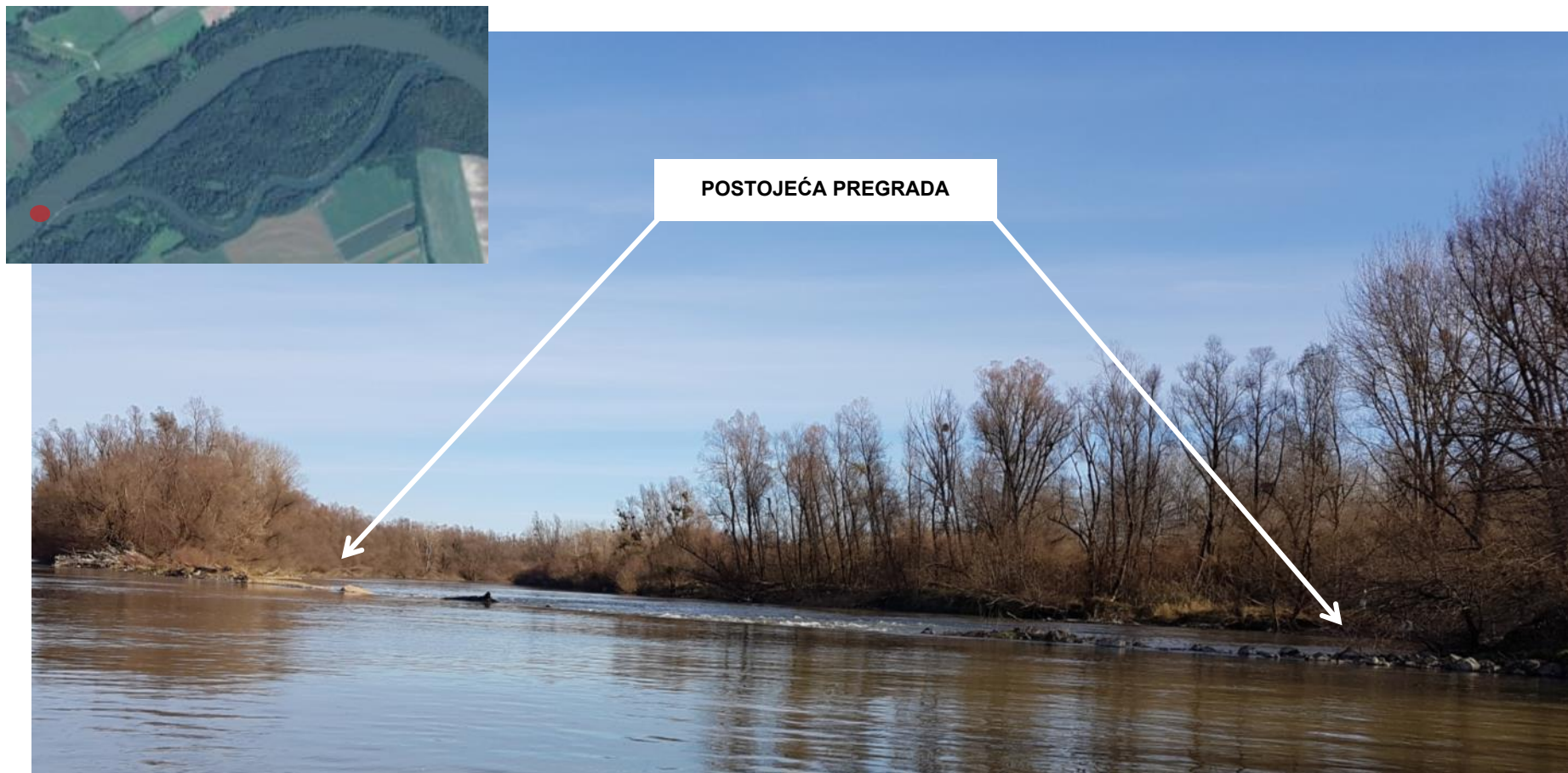
Slika 2-3 Fotografija postojeće pregrade na ulazu u rukavac C.6 (pogled sa uzvodne strane pregrade – iz korita rijeke Drave)
