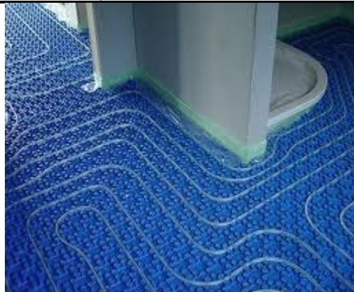
Slika. Montaža podnog grijanja
