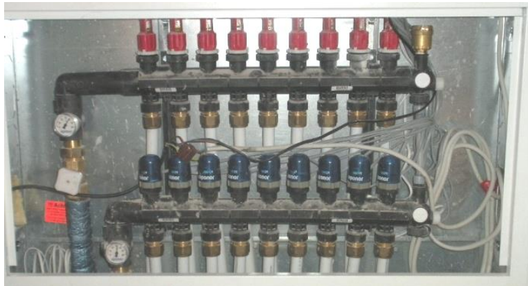
Slika. Razvodni ormar grijanja
