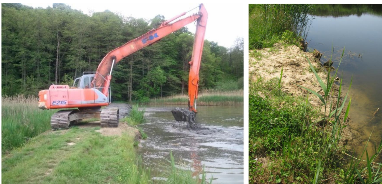
Slika 2.2 Strojno uređenja jezera i sanacija obale od strane športsko-ribolovnih udruga (Izvor: Idejno rješenje)
