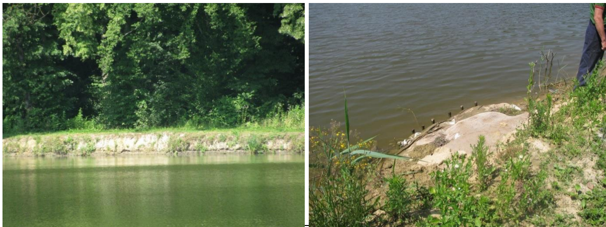
Slika 2.13 Izgled erodirane obale jezera i pokušaj sanacije materijalom iz jezera (Izvor: Idejno rješenje)
