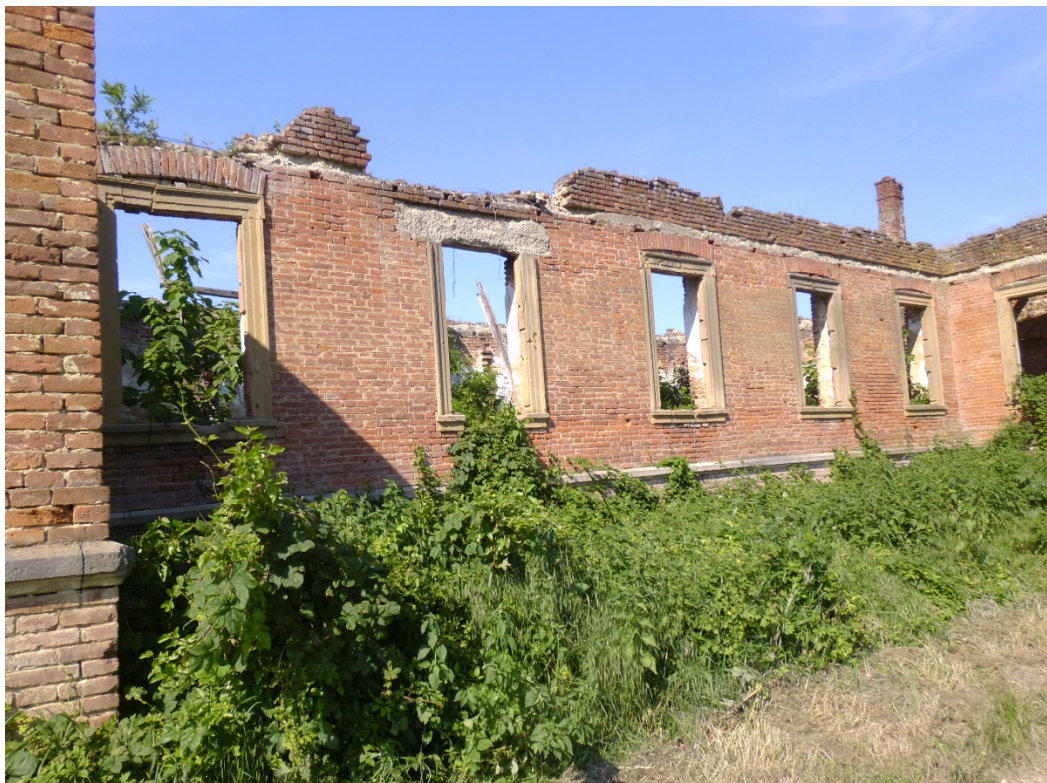
Slika 1 Postojeće stanje građevine
