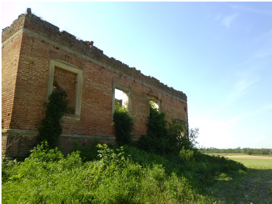
Slika 3 Postojeće stanje građevine
