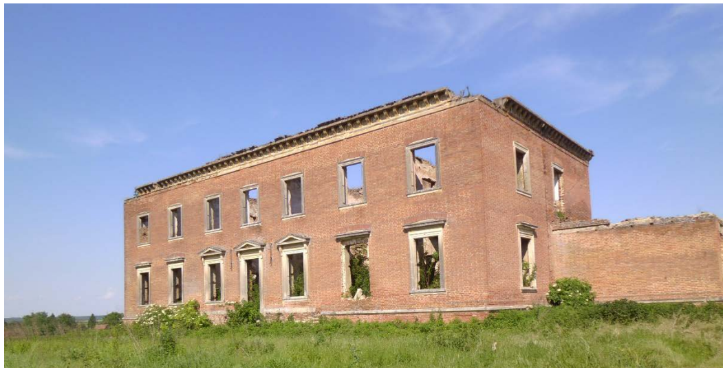
Slika 2 Postojeće stanje građevine
